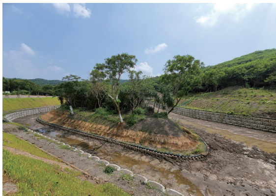
圖 4-60 屏東縣恆春鎮野溪整治工程
