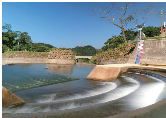
圖 4-61 臺中新社區抽藤坑溪整治工程
