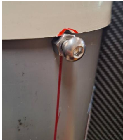
底座使用3支膨脹螺絲固定端點
